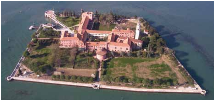
L'Isola di San Lazzaro degli Armeni - dopo la ristrutturazione e il consolidamento del muro perimetrale 2004
